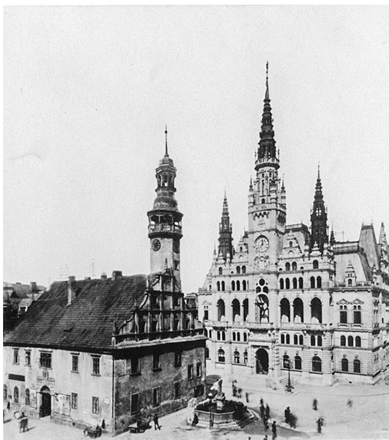
↑ Liberecké Staroměstské náměstí po stavbě nové a před demolicí staré radnice, 1893
