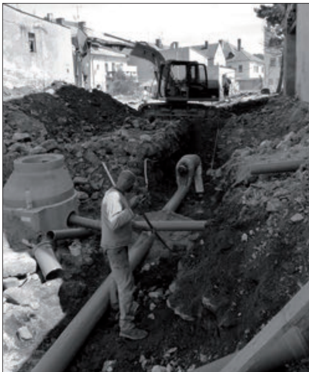
Obr. 6. Frýdlant – přestavba to- vární u nádraží ČSAD – pracovní snímek.
