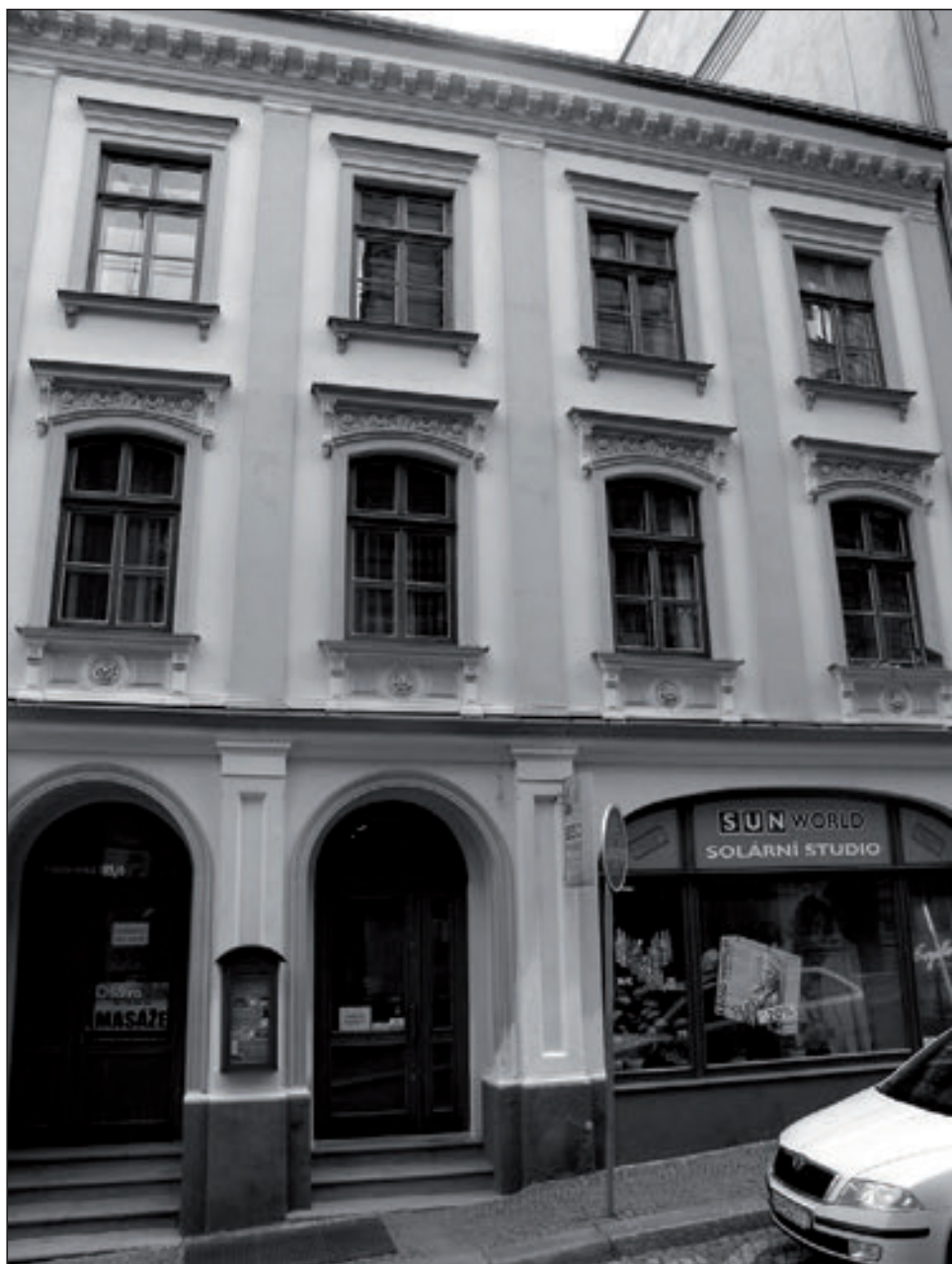
Obr. 1. Dnešní podoba domu čp. 185 -I ve Frýdlantské ulici pochází z přestaveb na konci 19. století.
