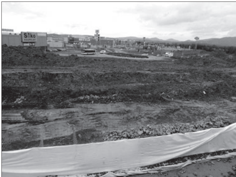
Obr. 11. Celkový pohled na výstavbu nové budovy firmy Decathlon v severní liberecké průmyslové zóně.
