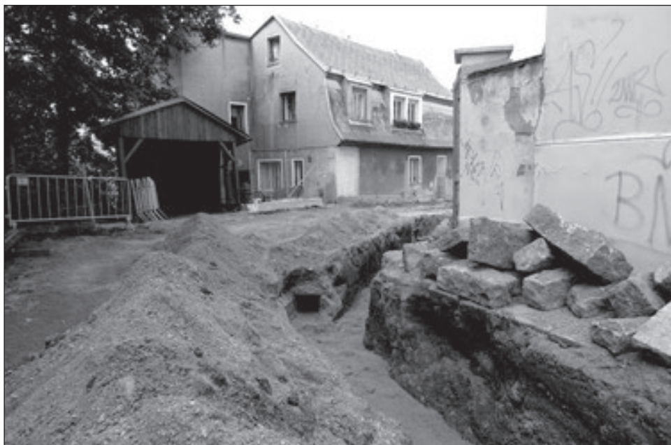
Obr. 9. Do léta roku 2010 sloužící původní kamenný kanál odkrytý v ulici Na Ladech a v dalších přilehlých ulicích během rekonstrukce kanalizace a plynovodu v letních měsících 2010.
