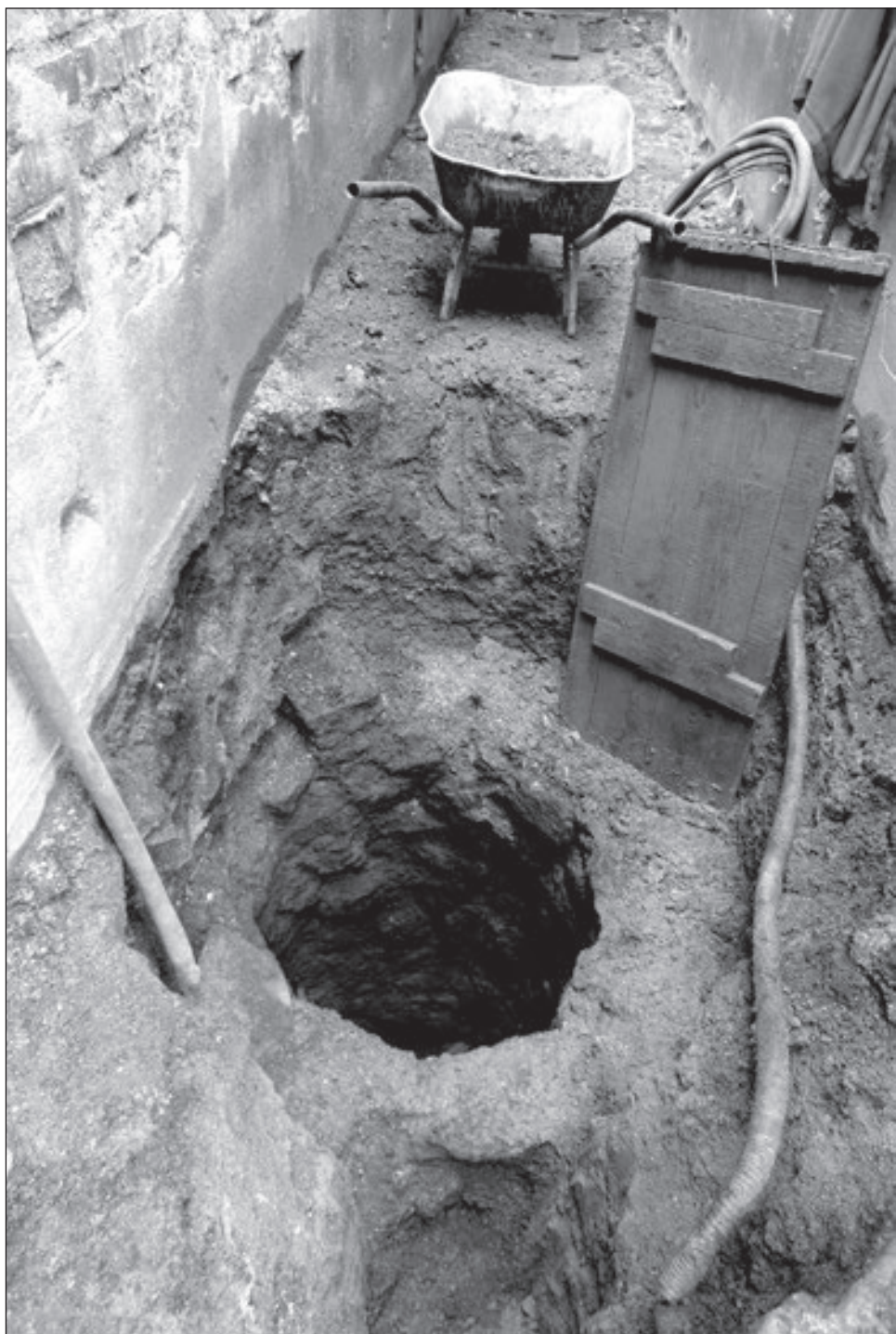
Obr. 10. Výzkum staré studny v průchodu k domu č. p. 223/36 ve Studničné ulici.
