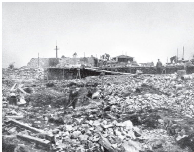
↑ Staveniště Nového ještědského domu v roce 1906
